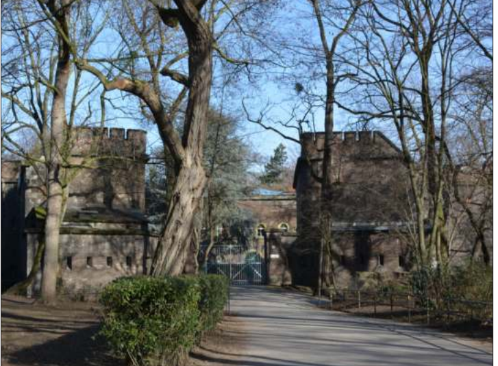
Zugang zum Fort X am Neusser Wall (10)
